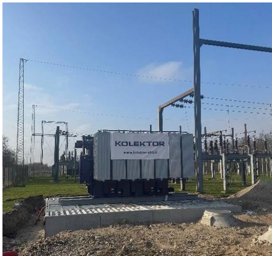
FIGUR 1 NY TRANSFORMER HOVEDSTATION LINDØ
