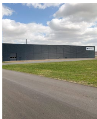
SP Mouldings nye lagerbygning i Stoholm
